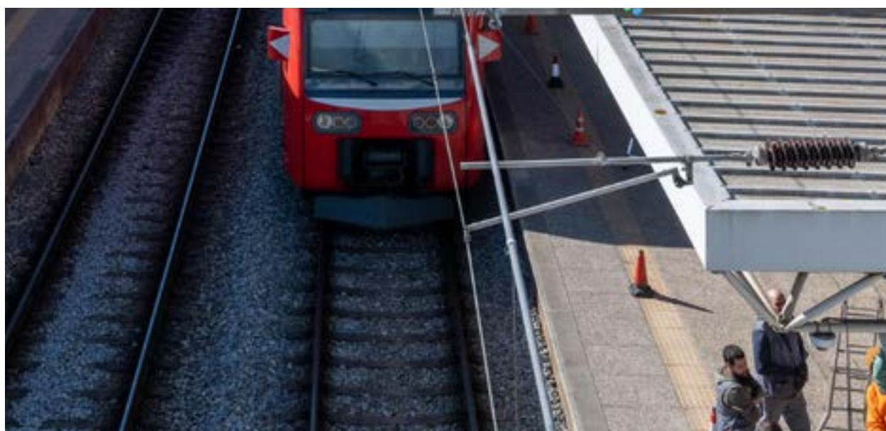
O Presidente da CM Loures, Ricardo Leão visitou as obras da Empreitada da estação Ferroviária de Sacavém
